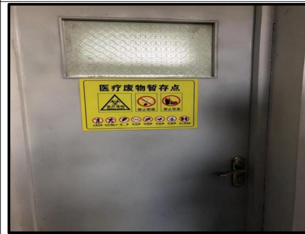
医疗废物暂存间
